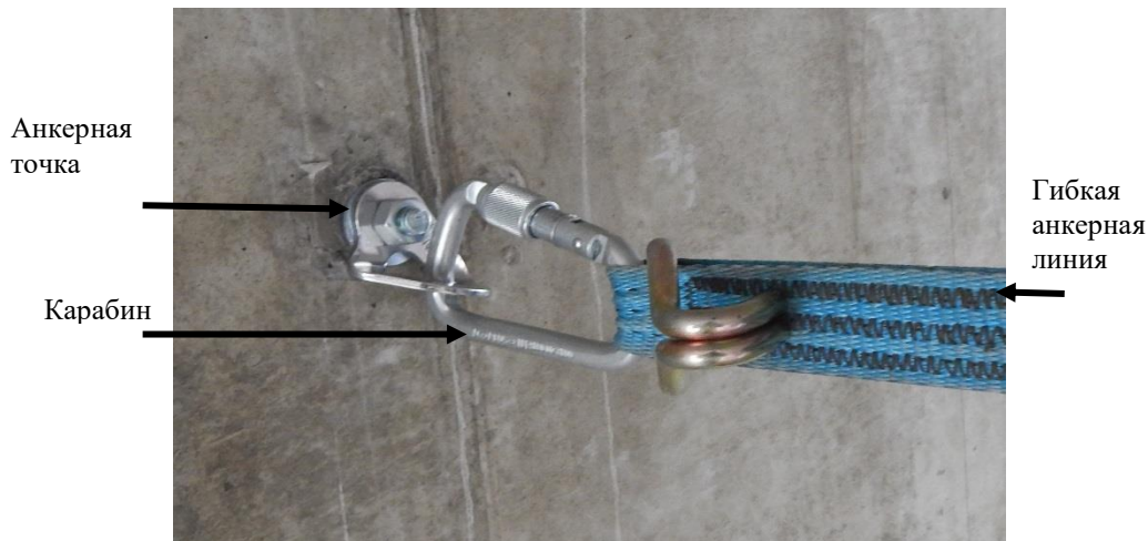
Фото 2. Закрепление системы обеспечения безопасности к пилону
