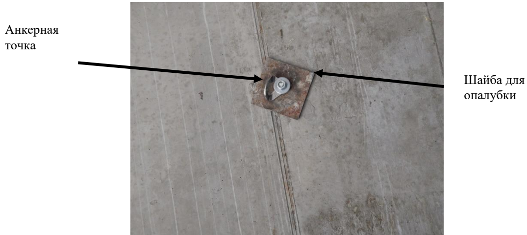
Фото 5. Закрепление системы обеспечения безопасности к пилону
