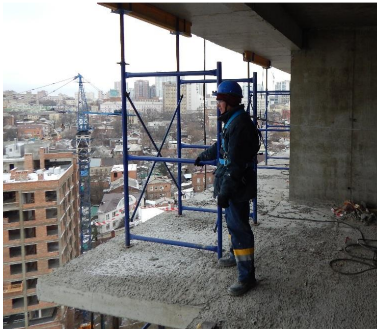
Фото 1. Пример объекта для выполнения работ
