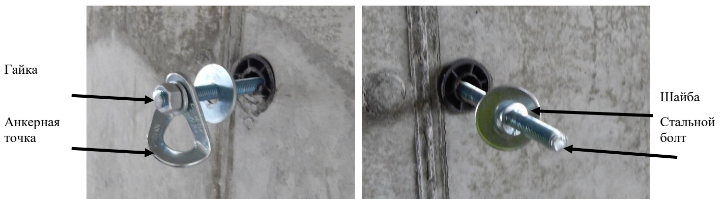
Фото 3, 4. Способ крепления анкерной точки
